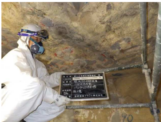
【ガス冷却室パッチング補修後】
