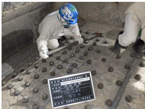
【焼却炉分散ノズル整備中】
