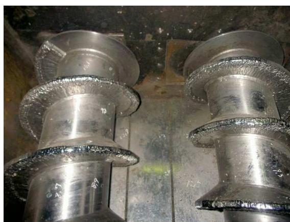
【給じん装置点検中】
