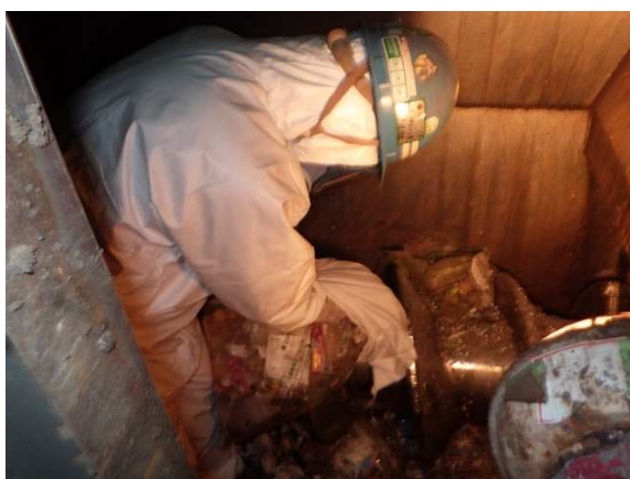
【給じん装置清掃中】
