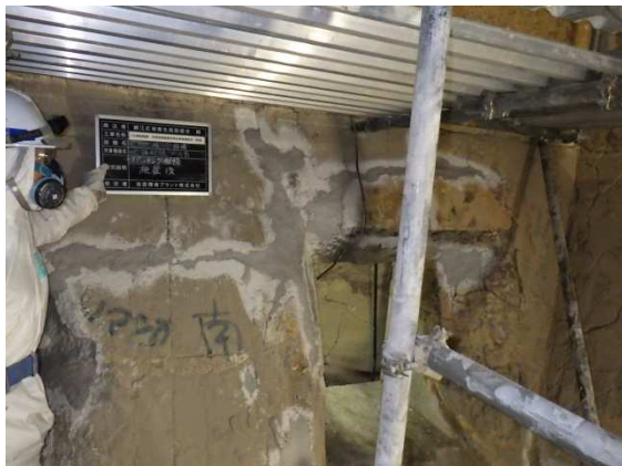
【焼却炉パッチング補修後】
