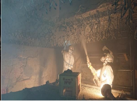
【ガス冷却室点検扉補修作業】
